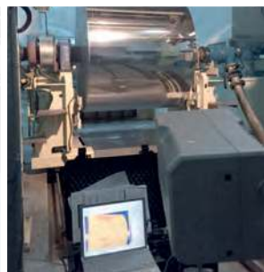
Kontrolle mit der Wärmekamera
