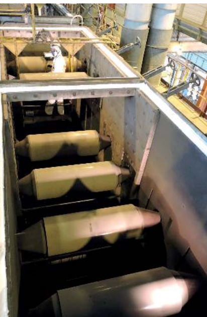
Contrôle dans un four
