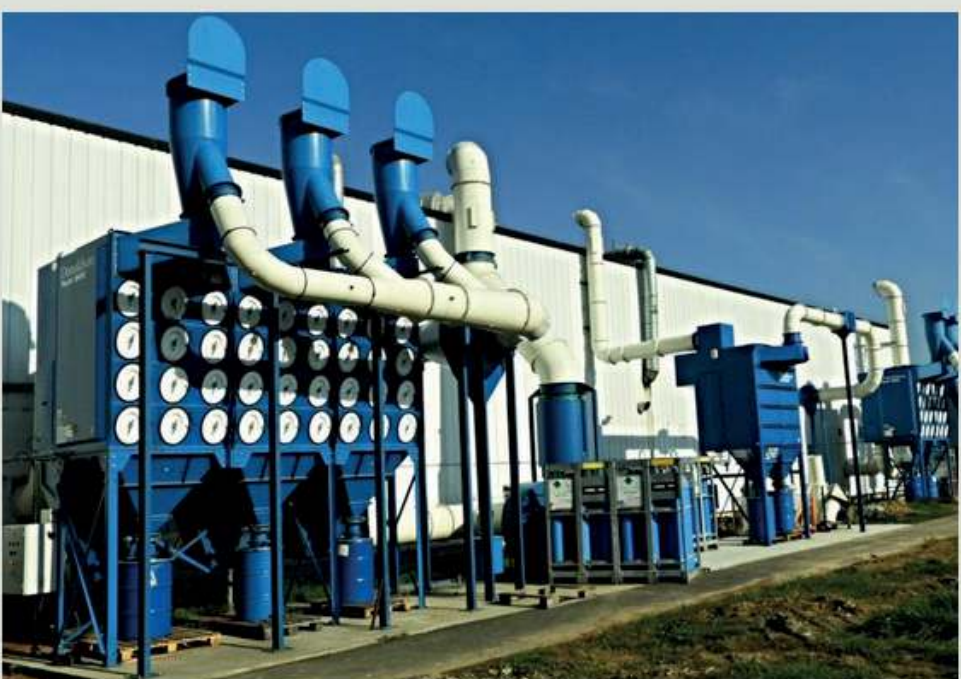
PMG OUEST COATING : Mise en place d'un système de filtration d'air plus actuel.
